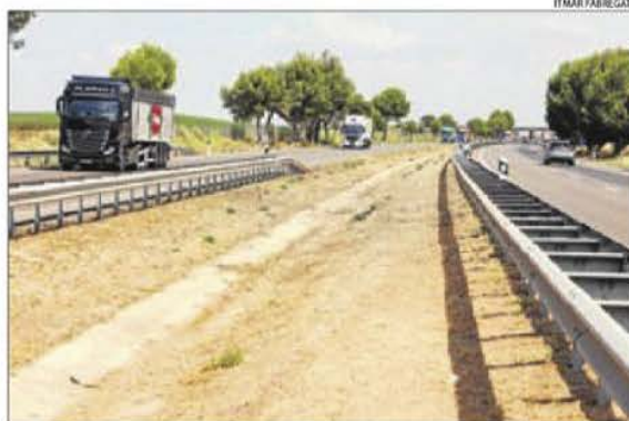
El vehicle va sortir per la mitjana en aquesta zona i va caure d'un pont.
