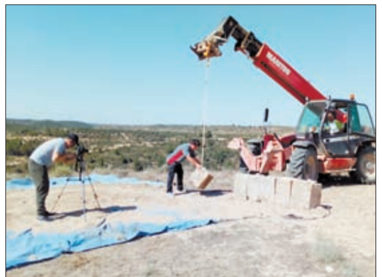
FOTO: Diputació/ Els tècnics col·locant les primeres pedres de l'arc
