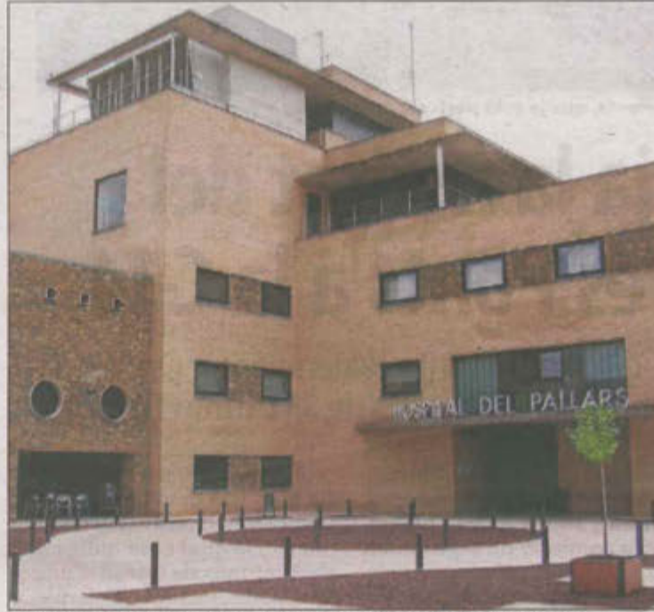
Imatge d'arxiu de la façana de l'hospital del Pallars, a Tremp.
