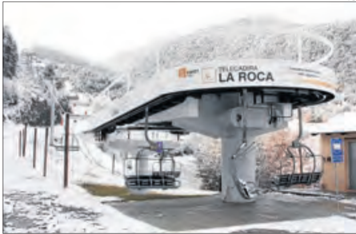
El telecadira de la Roca que serà substituït per un de nou.
