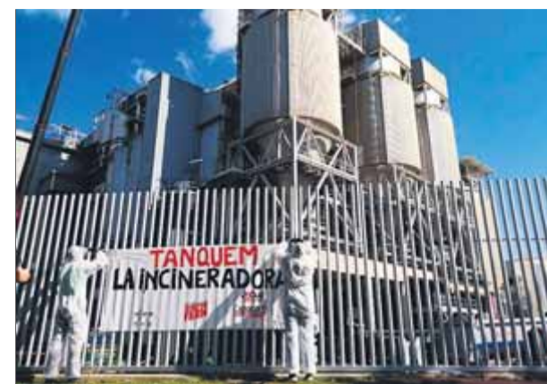
Els militants de la CUP de Barcelona van reclamar el tancament de la planta de Tèrsa ■ EL PUNT AVUI
