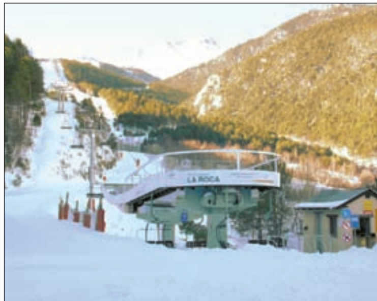
FOTO: ACN / Imatge del telecadira d'accés a pistes, que està espatllat
