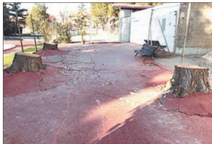
FOTO: Aj. la Granja / Imatge del paviment abans d'iniciar les obres
