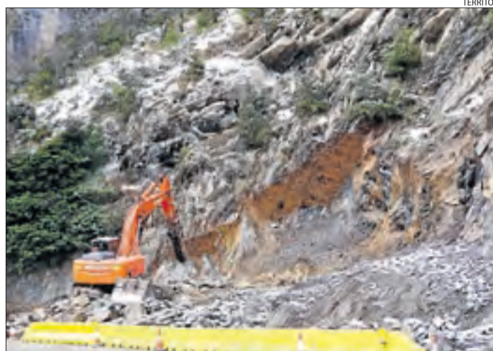
Les obres per al túnel de Tres Ponts a Organyà.
