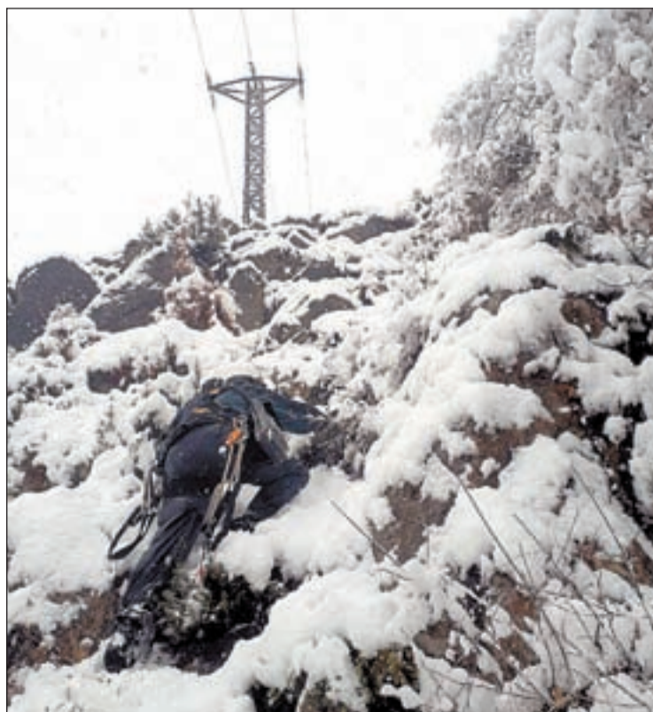
FOTO: Endesa / Un operari d'Endesa escalant ahir per reparar una avaria
