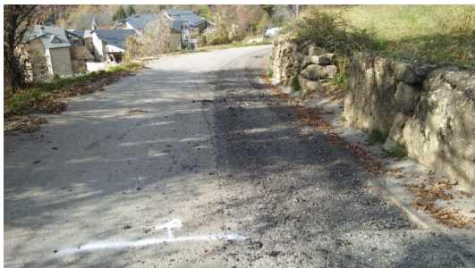
Detall del fresat d'una franja d'un metre al marge de la cuneta de formigó existent
