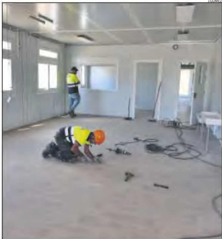
Els treballs per habilitar els mòduls.
