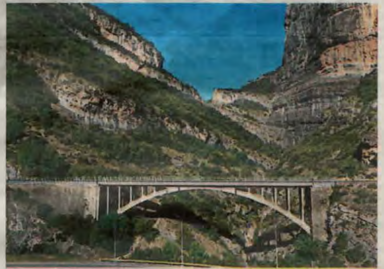
FOTO_FGC Imatge del vessant 17 de la línia de la Pobla
