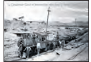
Canal de Seròs en construcció.
