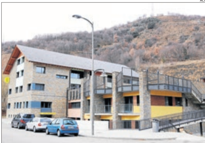
L'edifici on es traslladarà la seu del consell del Sobirà.
