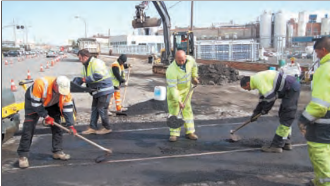
ADIF MILLORA EL PAS A NIVELL DEL POLÍGON INDUSTRIAL EL SEGRE DE LLEIDA Operaris de l'Administrador d'Infraestructures Ferroviàries (Adif) van realitzar ahir tasques de millora de la capa de rodadura del pas a nivell del ramal de la línia de la Pobla que creua el Polígon Industrial El Segre de Lleida en direcció a l'estació del Pla de Vilanoveta. Els treballs tenen per objectiu millorar la seguretat en aquest punt. FOTO: Tony Alcántara
