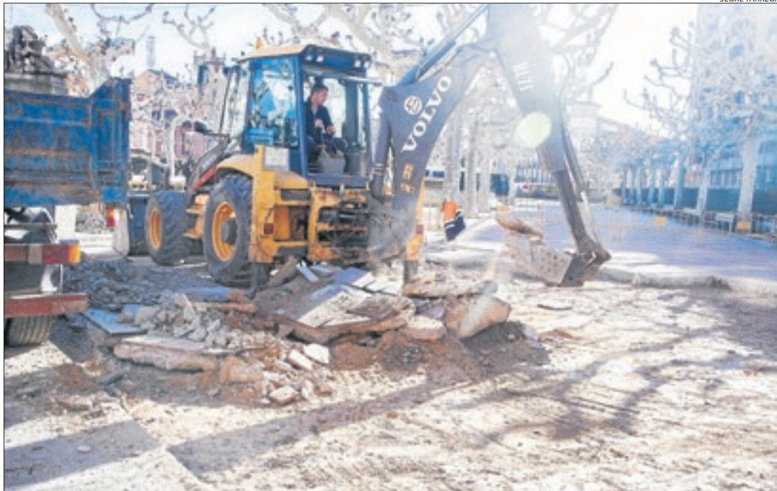
Les obres al Pati, centre neuràlgic de Tàrrrega, que van començar ahir.
