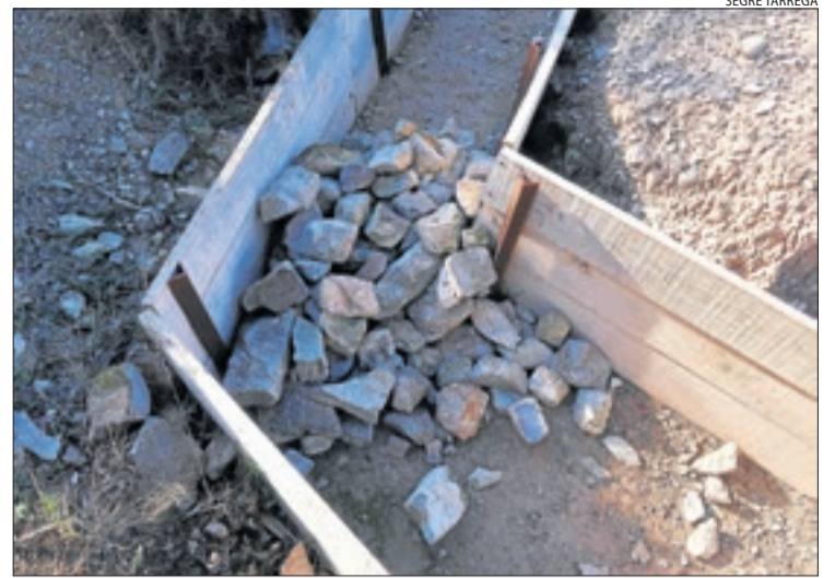
Imatge dels desperfectes a les trinxeres de Montgai.
