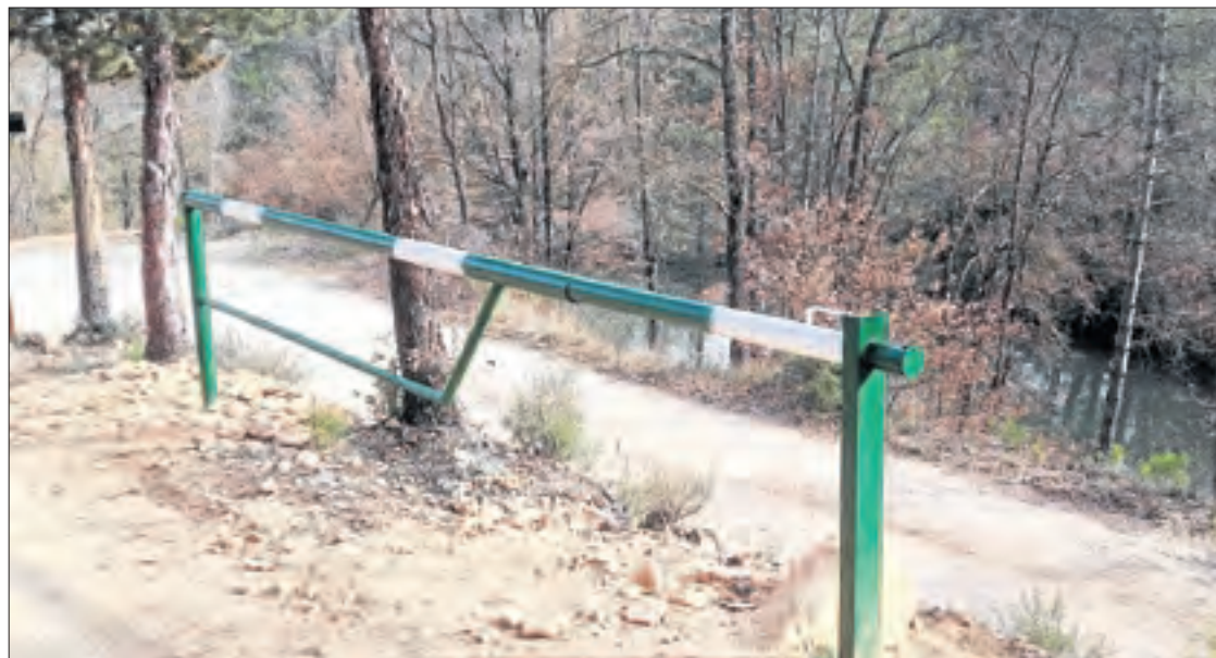
Una de les dos barreres que s'han instal·lat a la Noguera, a l'accés al coll d'Ares.
