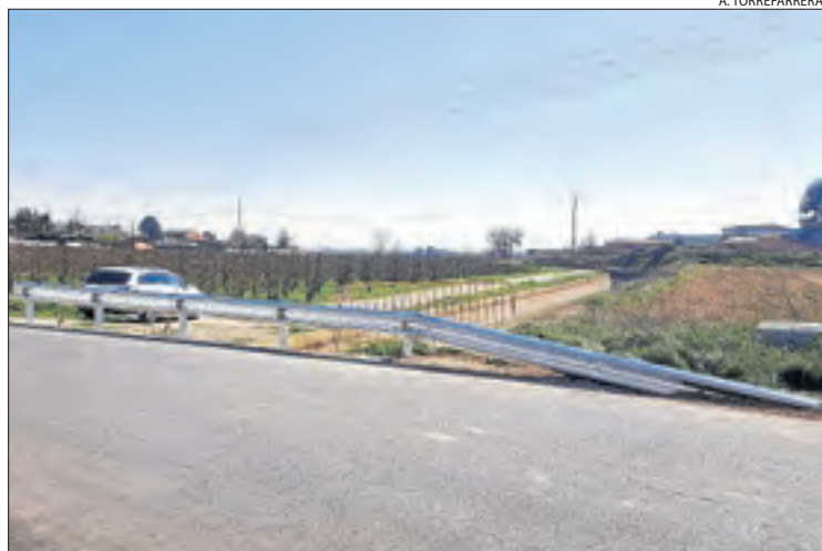
Imatge de la tanca que ha estat reposada recentment.
