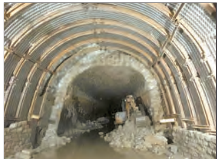
FOTO: / Imatge de les obres al Túnel de Montclar
